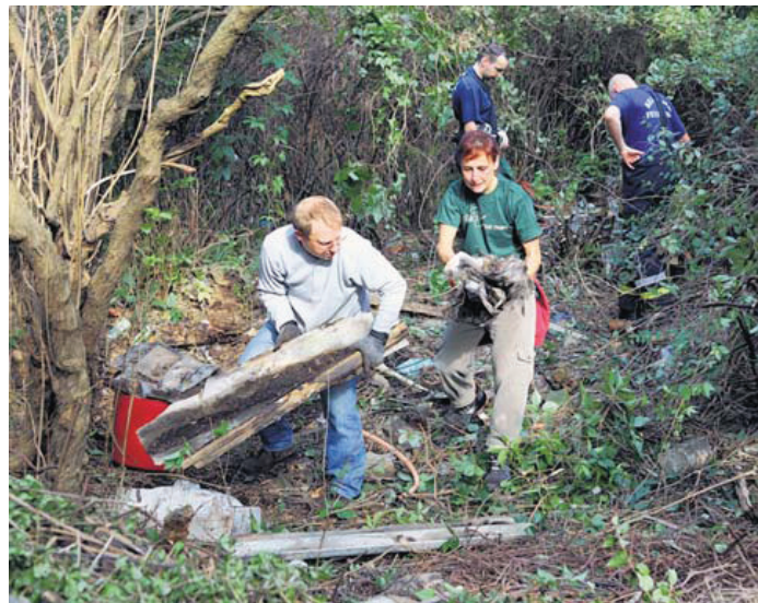
Die Feuerwehr beseitigte das Unterholz und gab den Blick frei auf Schutt und Geröll, den die Karlshorster „Sammelfreunde“ entsorgten.
